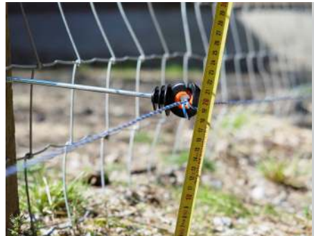
Montage eines Stopppdrahtes
